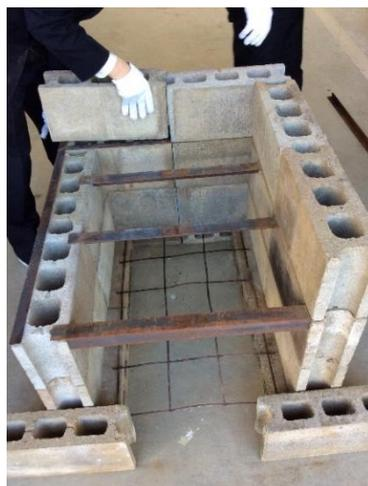
② 自作の金具を取り付けながら組み上げる
