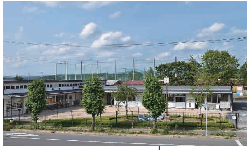
農場管理室&農業実習棟
